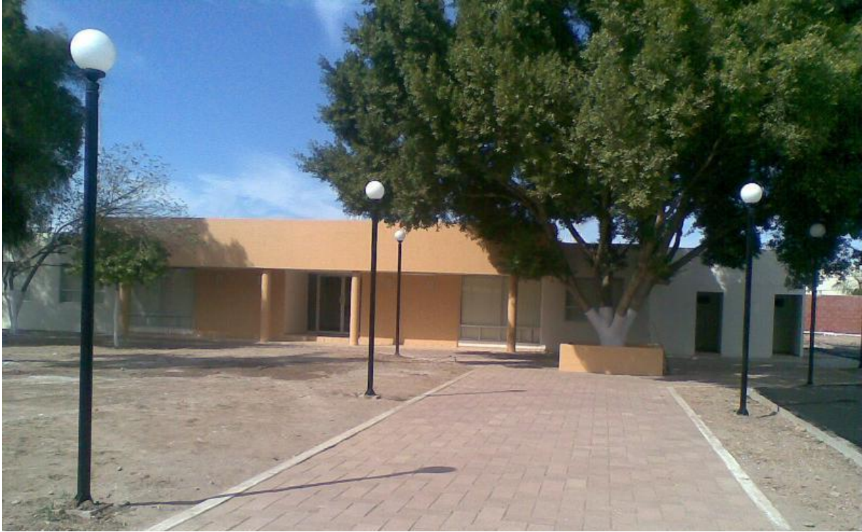
Edificio Juzgado Familiar de Navojoa.
